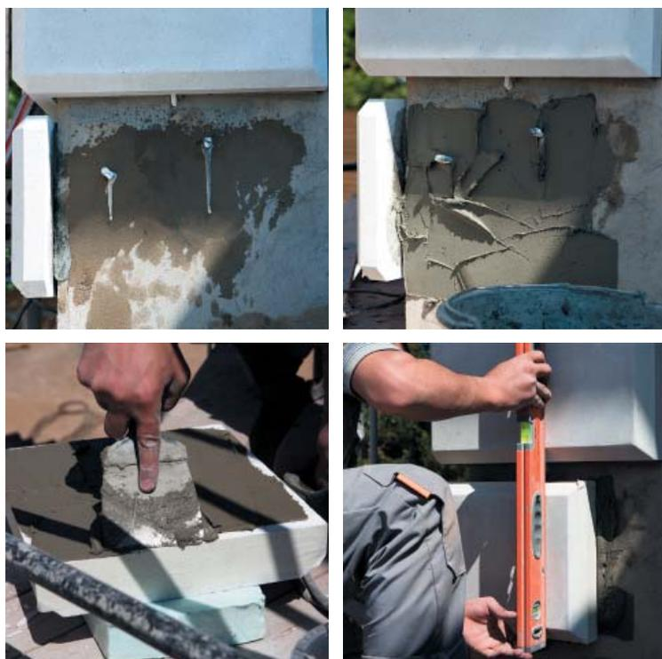
После установки изделий необходимо обеспечить неподвижность на срок высыхания клея. Клеевой шов должен быть максимально заполнен и не содержать пустот. Зазоры выдерживаются с помощью монтажных пластиковых клиньев.
