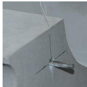
Изделие вешается на анкеры, и фиксируется клеевой смесью. При точном позиционировании тяжелых элементов используются клинья и технологические анкеры, играющие роль упоров.
