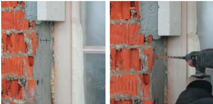
Устанавливается анкер. При необходимости анкер может дополнительно фиксироваться расширяющимся клеем, например марки «Клейберит».
